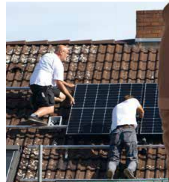
Bei der „Aufdach-Montage“ werden die Solarmodule auf einem Metallrahmen über den Dachziegeln montiert.
