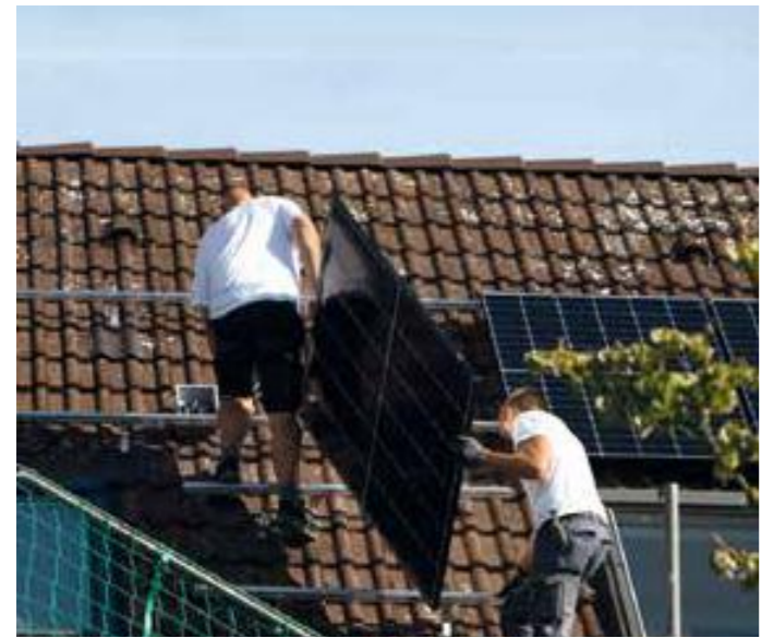
Bei der „Aufdach-Montage“ werden die Solarmodule auf einem Metallrahmen über den Dachziegeln montiert.
